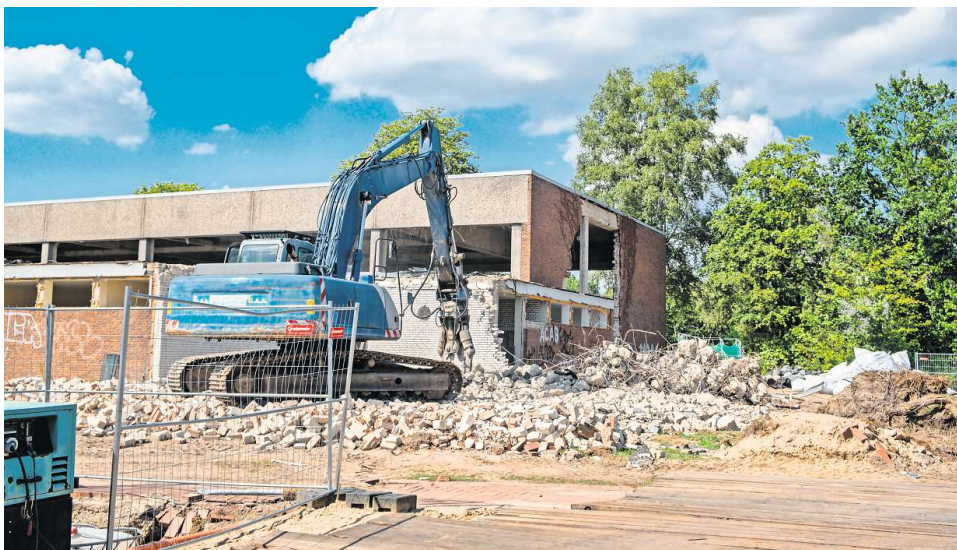
Der Abriss der Turnhalle am Gymnasium schreitet voran. Einige kleine Gebäudeteile sind bereits verschwunden.
